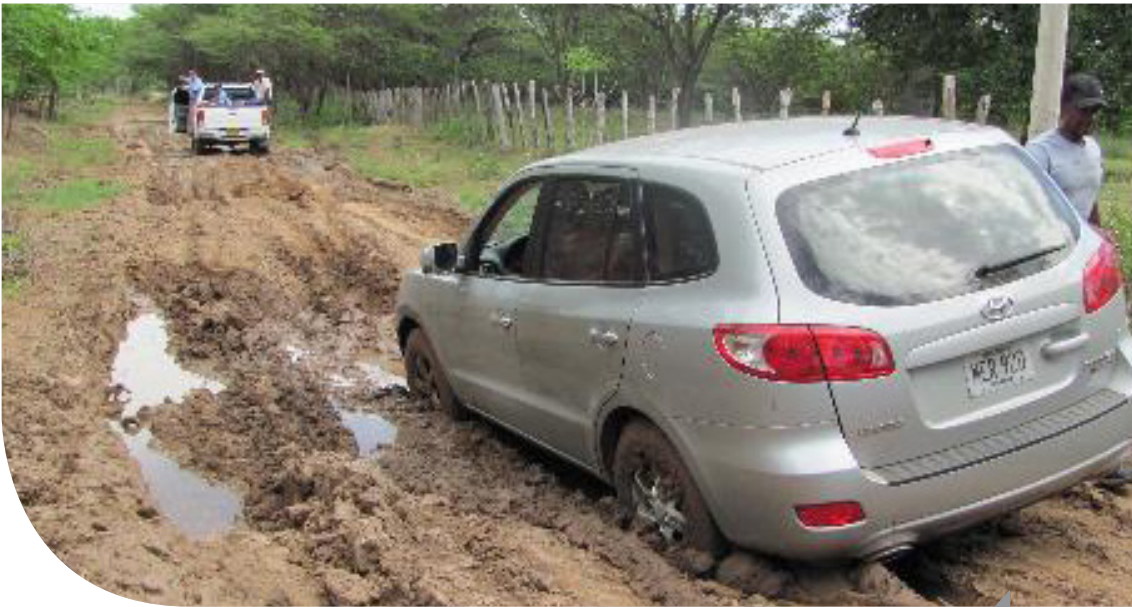
Vías terciarias afectadas por las lluvias
